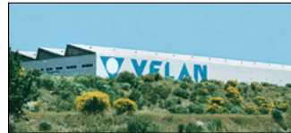
Lisbon, Portugal Velan Válvulas Industriais, Lda.
