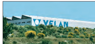
Lisbon, Portugal Velan Válvulas Industriais, Lda.
