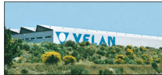
Lisbon, Portugal Velan Válvulas Industriais, Lda.
