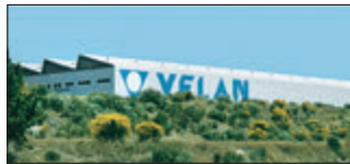
Lisbon, Portugal Velan Válvulas Industriais, Lda.
